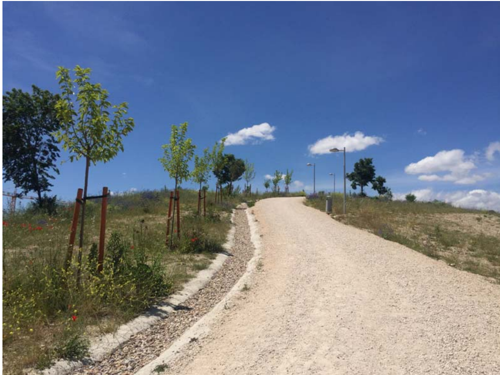
Figura 12. Cuneta revestida en hormigón camino de acceso - Parcela RL-V27
