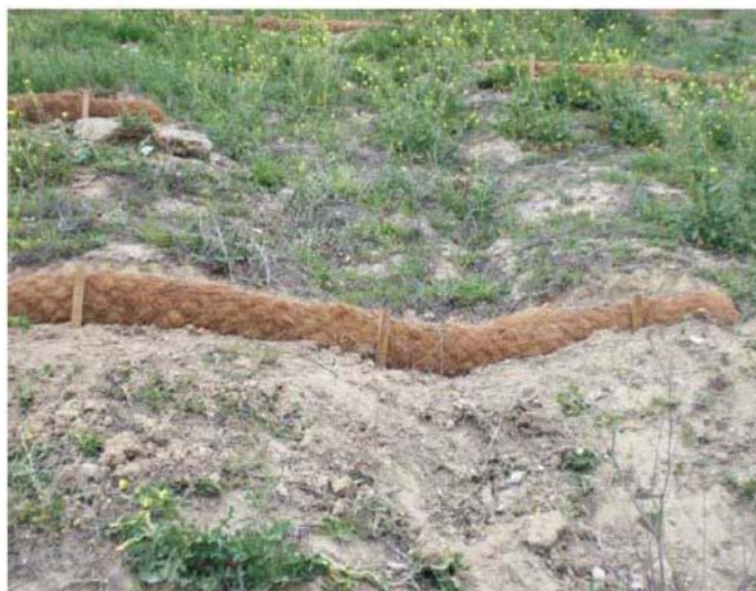
Figura 16. Detalle de biorrollo en talud. Fte: Manual estabilización taludes. Univ. De Córdoba
